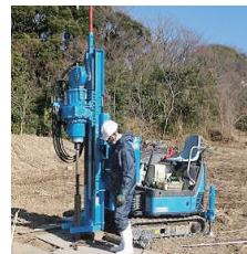
〈環境ボーリング〉
